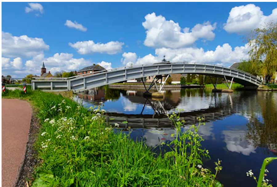
De aluminium brug in Bleskensgraaf.
